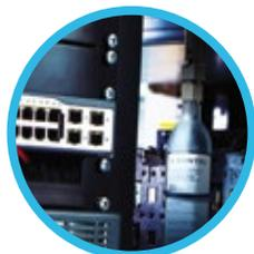
Средство газового пожаротушения (СГП) BONTEL представляет собой инновационное устройство, заправленное двуокисью углерода ( $\text{CO}_2$ ). СГП BONTEL предназначено для защиты от возгораний в распределительных щитах, электрошкафах, серверных и телекоммуникационных стойках и др.
